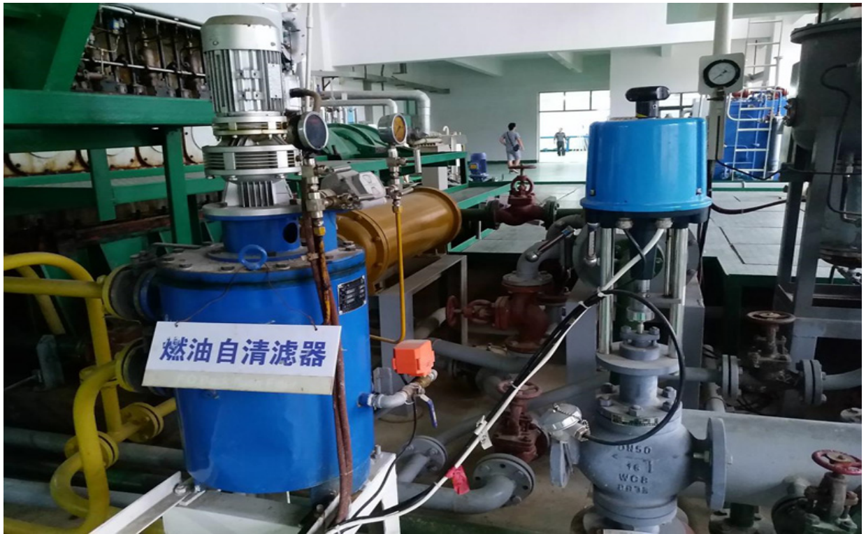
图 15 燃油自清滤器
